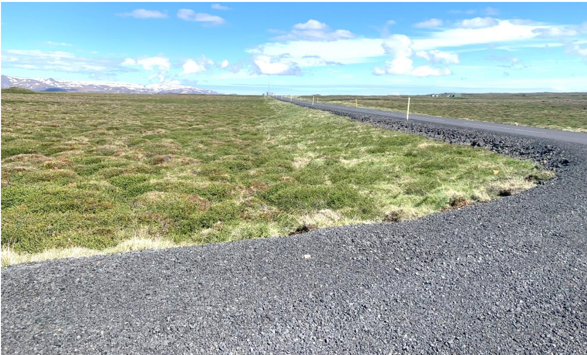
Mynd 3.4 Horft meðfram Þeistareykjavegi þar sem strengurinn mun liggja samsíða Þeistareykjalínu 2. Hér má sjá dæmi um vel heppnaðan frágang með því að geyma og endurnýta staðargróður, stefnt er að sama verklagi við frágang framkvæmda.
